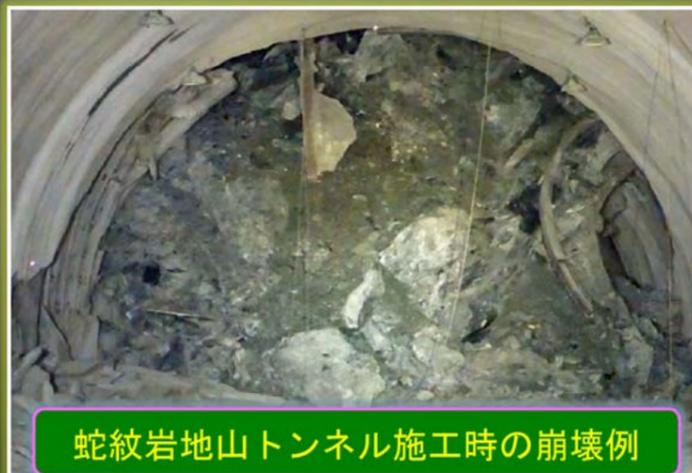
蛇紋岩地山トンネル施工時の崩壊例
